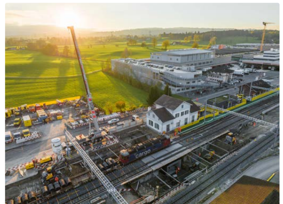
Bahnbaustelle Rothenburg der Marti Zentralschweiz (Bild: Franz Emmenegger)
