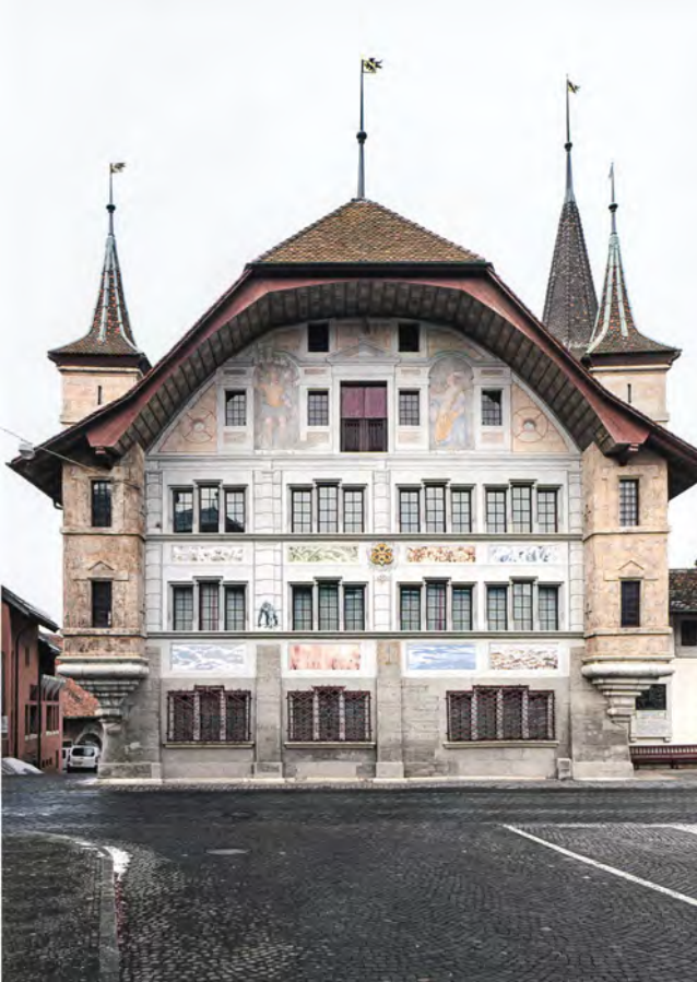
Abb. 55 Fassade des Schloss Büren an der Aare mit restauriertem Giebelfeld und acht Fassadenfeldern, welche nach einem Wettbewerb durch den Künstler Mercurius Weisenstein 2006 realisiert wurden.
