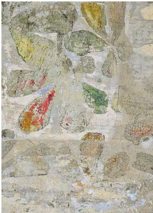
Abb. 37 Freigelegte Motive unter dem Fenster an der Nordfassade.
