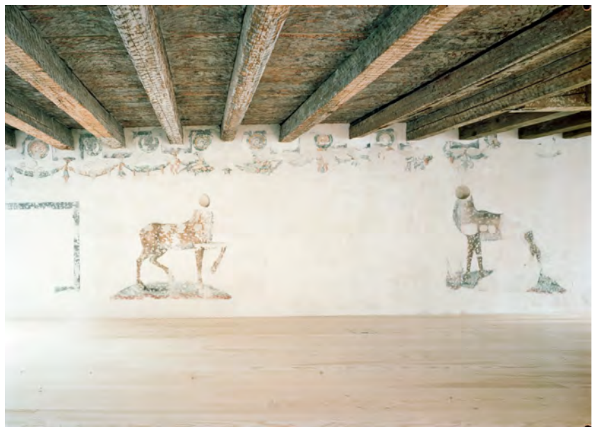
Abb. 51 Ackermannshof Basel, 1. OG, saniert 2009-2011 Es sind Fassungen aus verschiedenen Epochen sichtbar. Sie sind durch einen weissen Kalkanstrich in eine egalisierende Fläche eingebettet.
