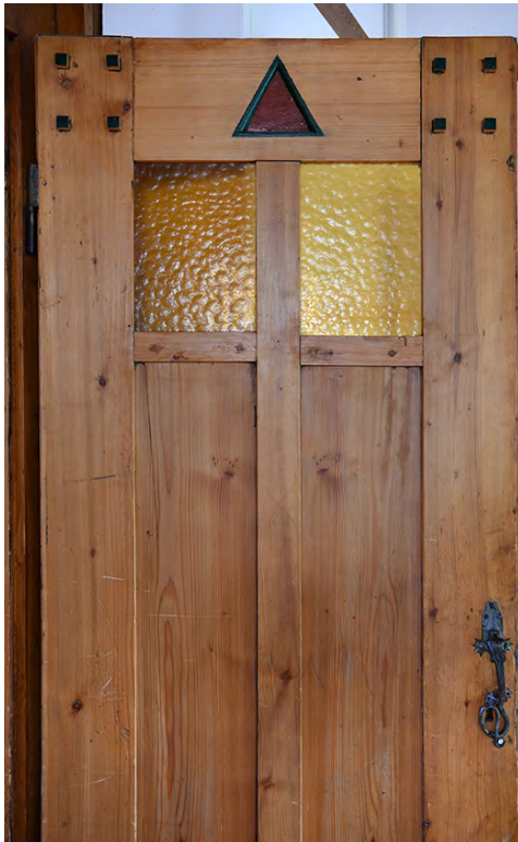
Abb. 14 Türblatt vom Salon mit eingelassenem Keramikdreieck und Holzwürfeln bei den Eckverblattungen.
