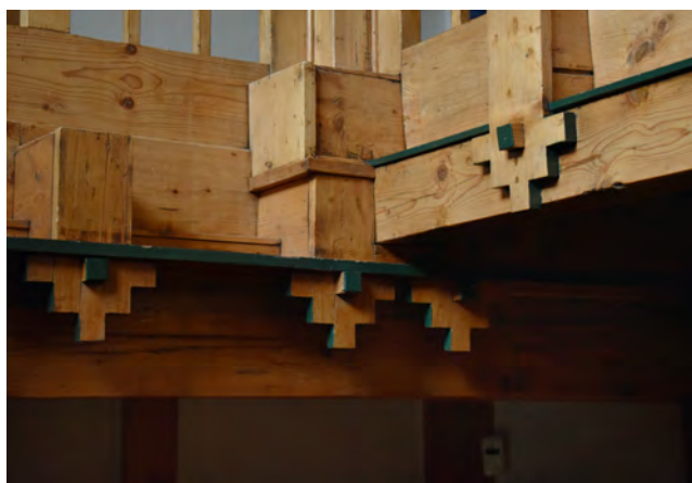
Abb. 36 Im Übergang von der Decke des Erdgeschosses zur Galerie sind die Balkenköpfe eingehaust und mit abgetreppten Zierelementen versehen.
