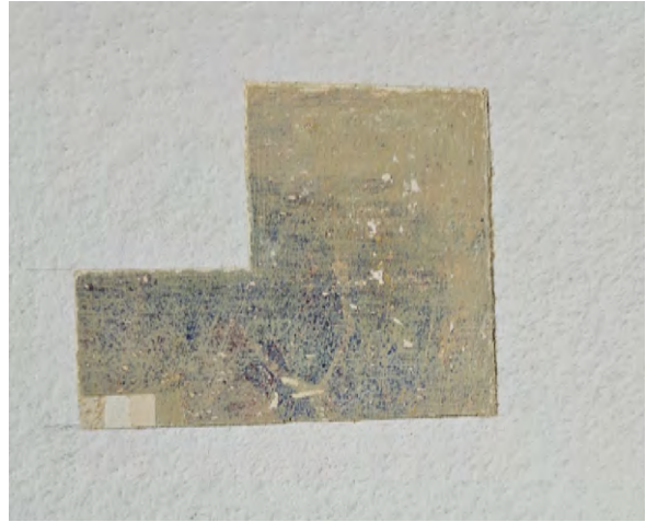
Abb. 47 Sondierung am Fries im Esszimmer. Motive und Farbigkeit wurden in kleinen Fenstern freigelegt und sind vage erkennbar.
