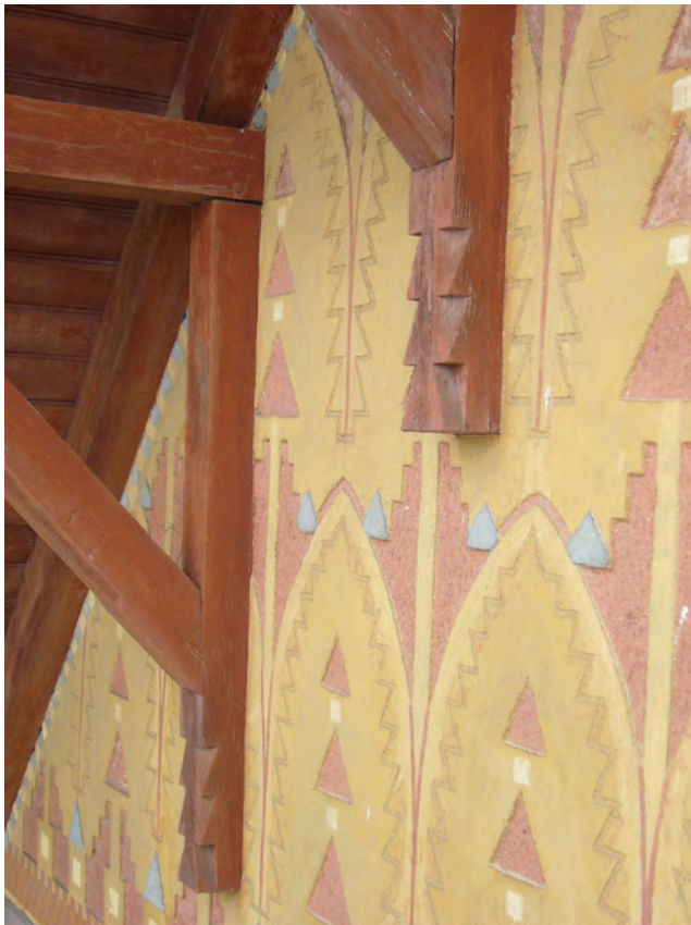
Abb. 3 Sgraffitofassade (Südost) mit Tannenmotiven und dreieckig eingekerbten Konsolen, die auf der Frontseite Tannen symbolisieren.
