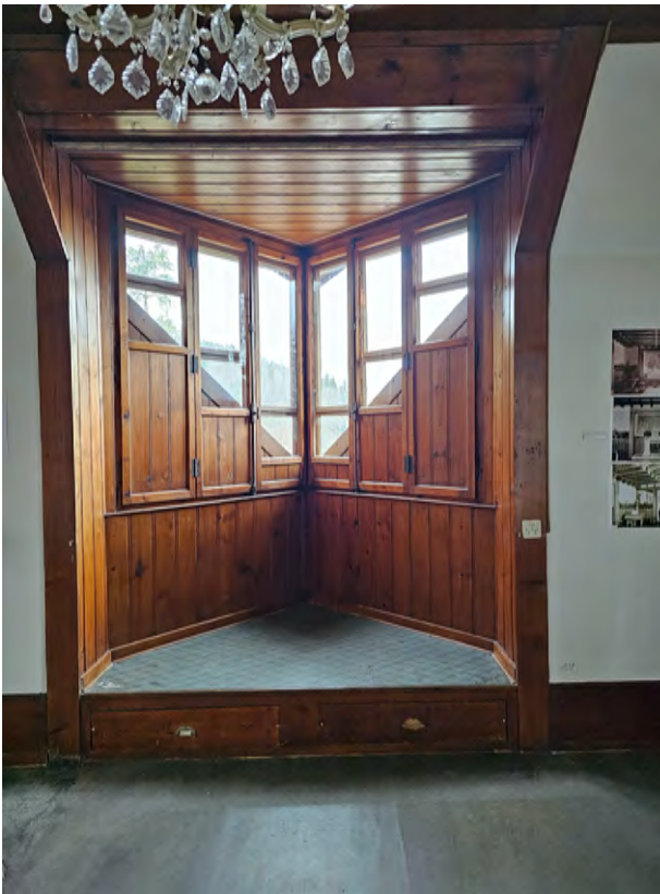
Abb. 45 Fensternische mit Podest.
