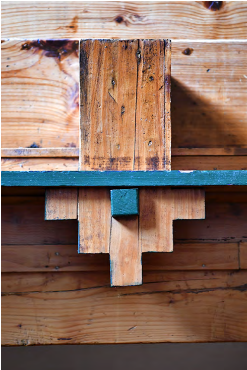
Abb. 13 Abtreppung bei Holzkonsolen und Verbindungen.
