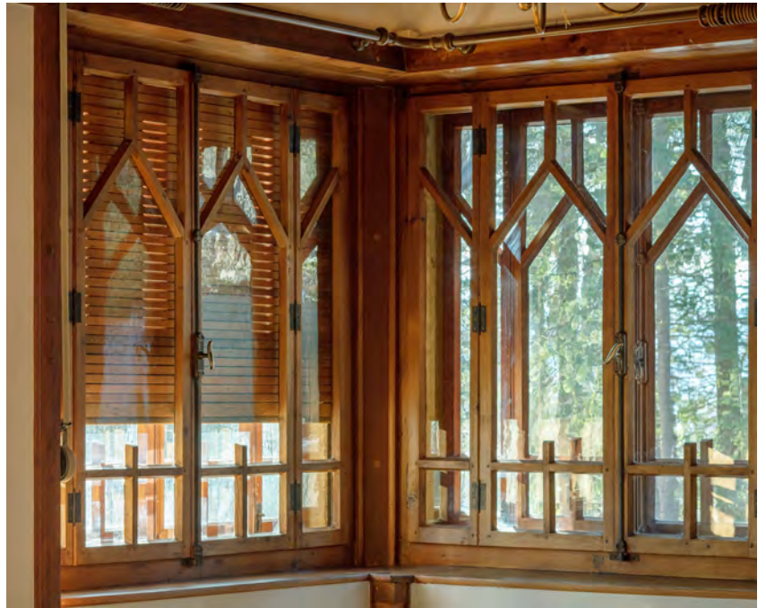
Abb. 15 Fenster Esszimmer, Überlagerung der tannenförmig angelegten Sprossen mit den lichtdurchlässigen Lamellen der Storen.
