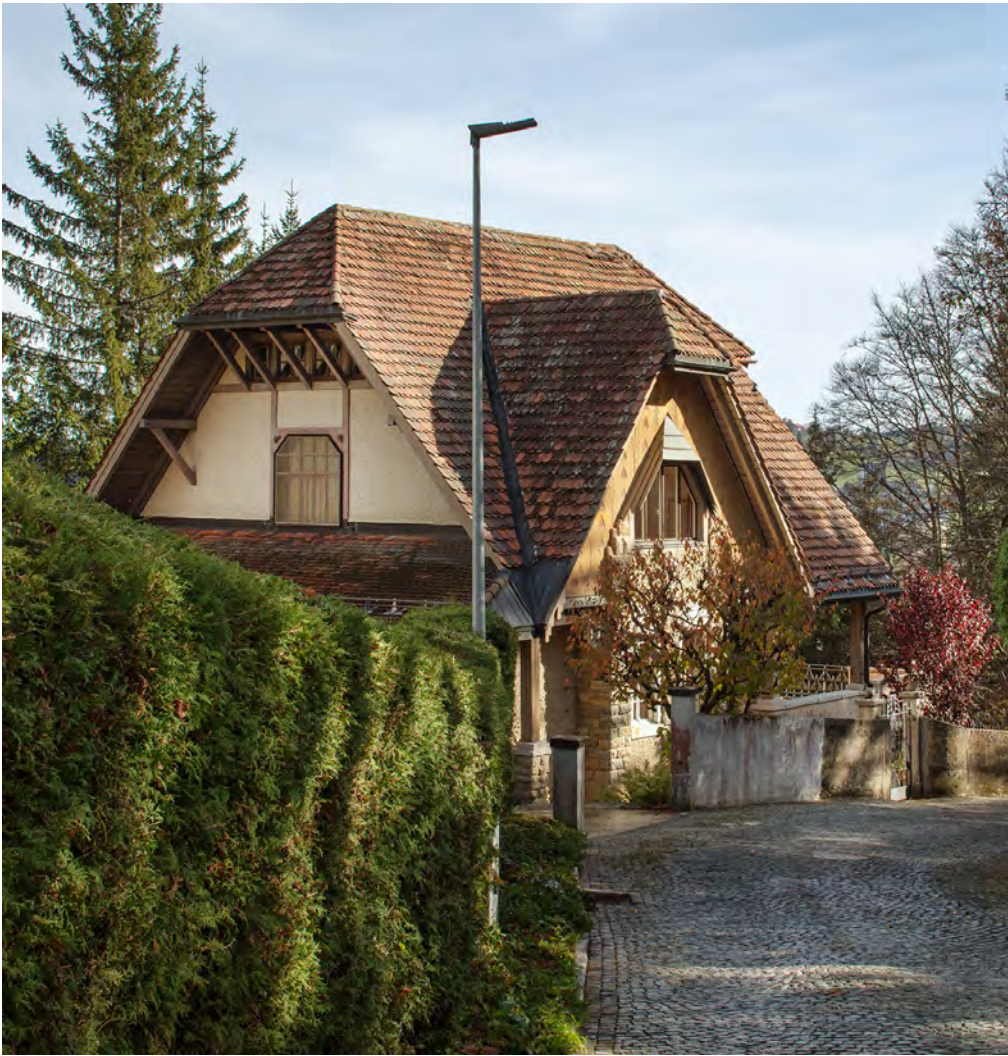
Abb. 25 Nord- und Westfassaden mit Dachformen und grossem Nordfenster, 2022.
