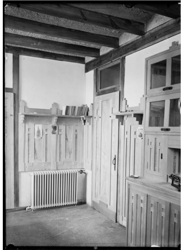
Abb. 20 Atelier Chapallaz in Tavannes mit raffinierten Holzfüllungen und abgetreppten Konsolen, erbaut 1905.
