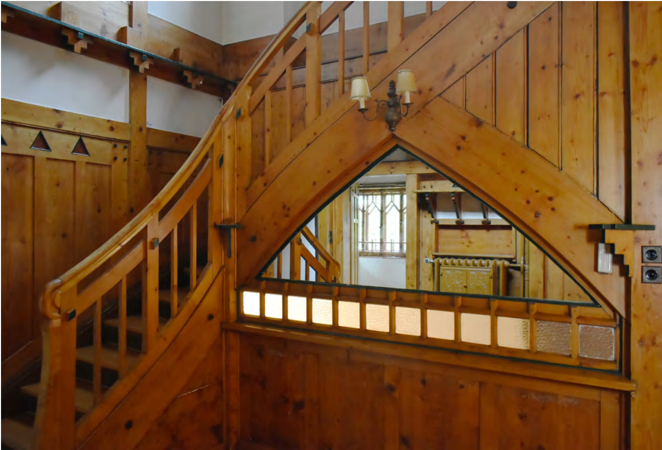
Abb. 33 Halle mit Spiegel und Fensterscheiben in der Holzverkleidung, welche den Raum durch ihr raffiniertes Lichtspiel grösser erscheinen lassen. Blick Richtung Nordwesten.
