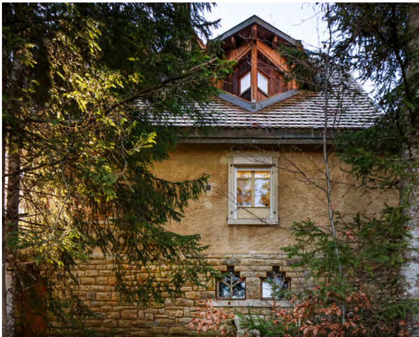
Abb. 31 Kellerfenster in abgetreppten Fassadenöffnungen.
