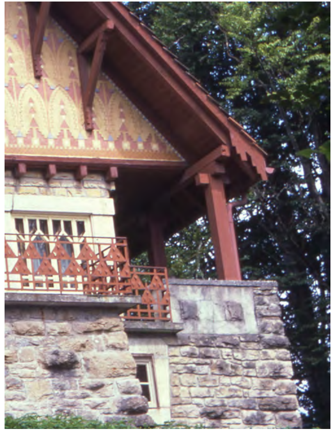
Abb. 5 Fassade Südost. Stirnladen mit Tannenzapfenmotiv, dahinter Holzkonstruktion mit dezidiert sichtbarer Holzverbindung. Die Aufnahme von 1978 zeigt eine oxidrote Farbfassung bei Holzwerk und Terrassengeländer.
